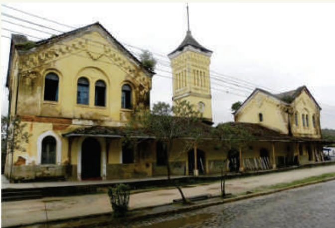
FOTO: A ESTAÇÃO ANTES DA REFORMA.
