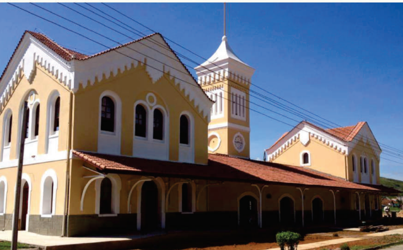
FOTO: A ESTAÇÃO DEPOIS DA REFORMA.
