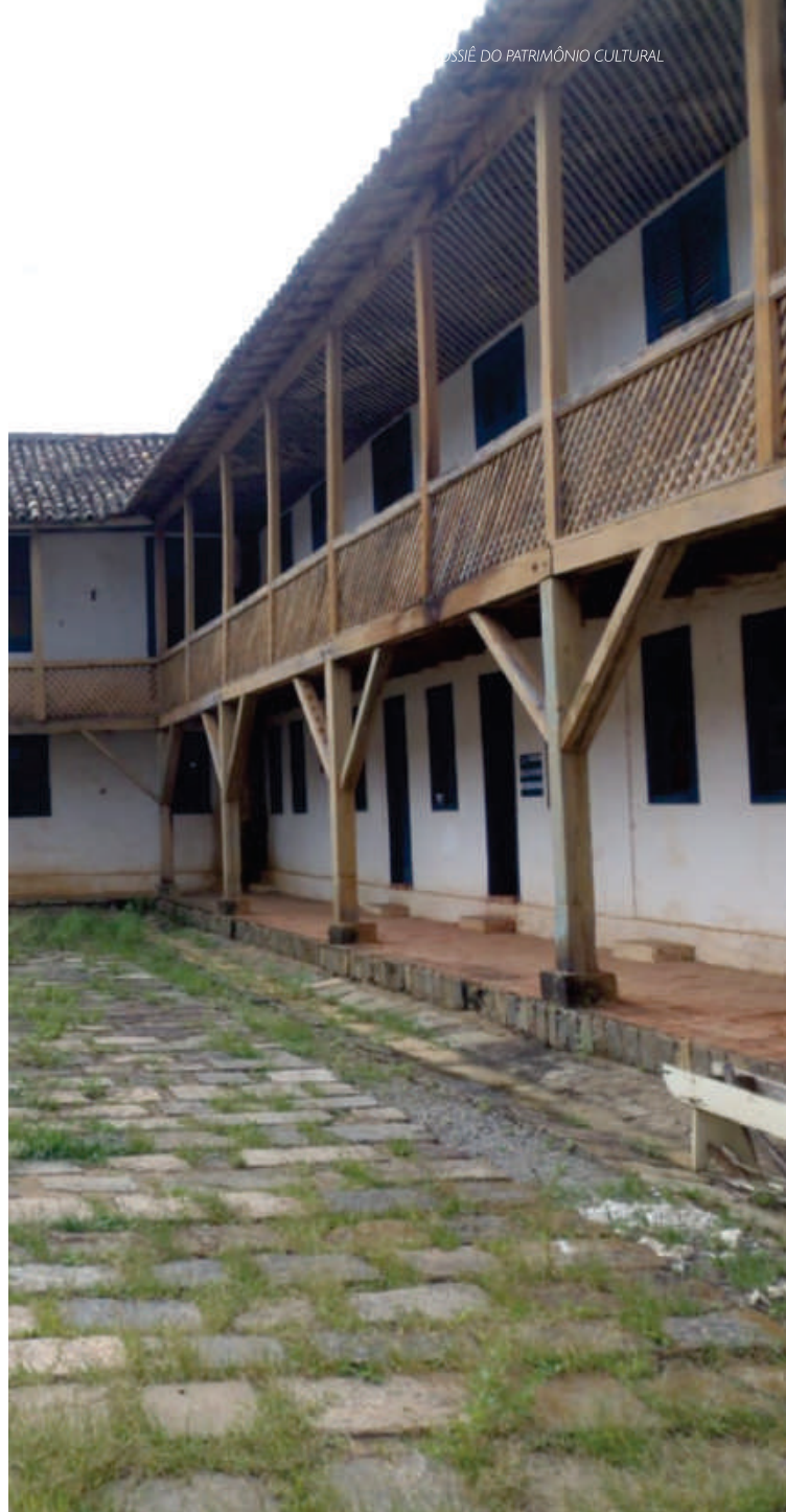
FOTO: PÁTIO INTERNO DA ANTIGA FAZENDA FREGUESIA.
