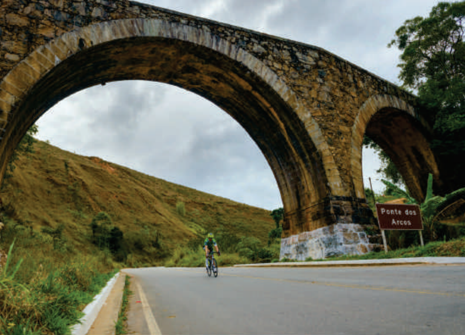
FOTO: PONTE DOS ARCOS, CONSERVATÓRIA. POR IGOR ALECSANDER.
